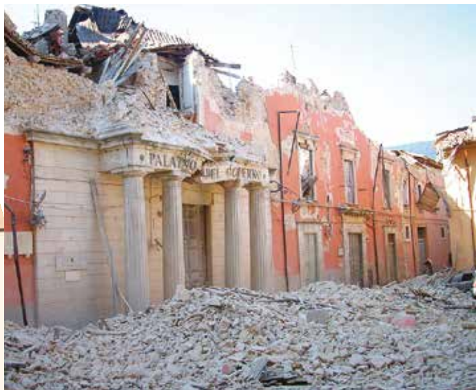
Danni causati da un terremoto
