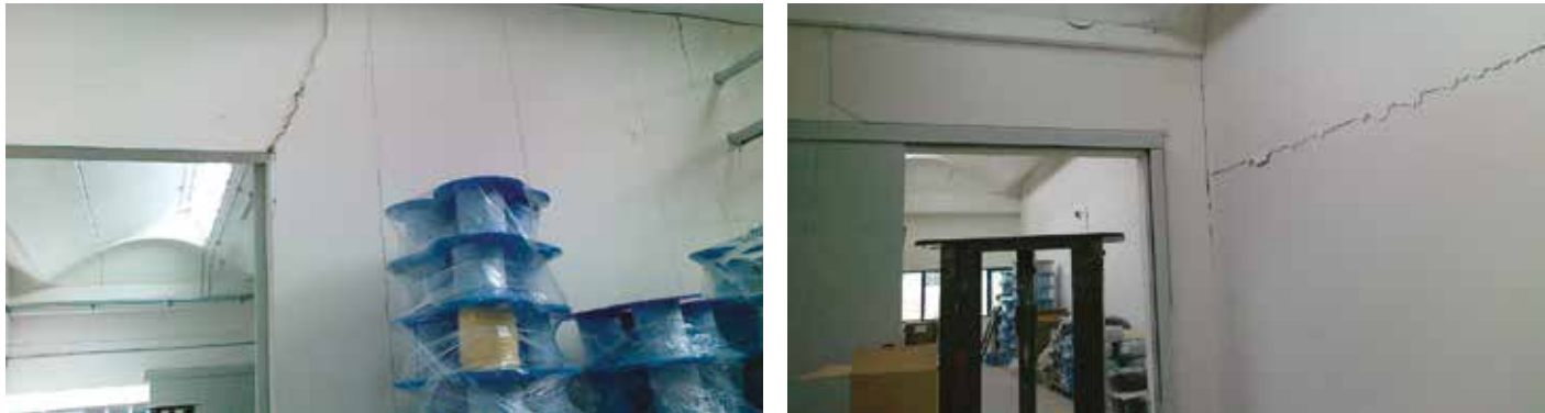
Danneggiamento di pareti in cartongesso standard (prive di dispositivi di scorrimento) a seguito di un terremoto
