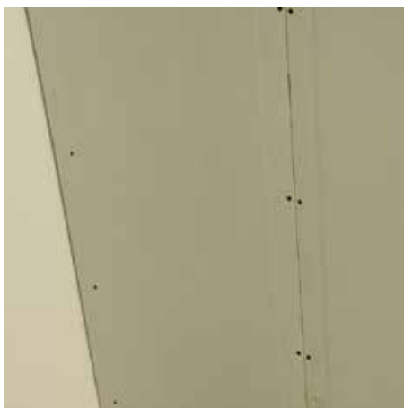
Avvitatura delle lastre solo sui montanti
