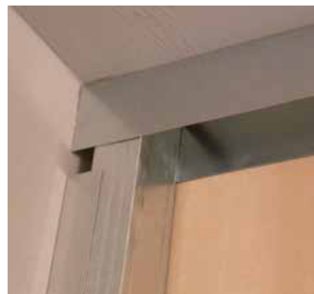
Giunto telescopico a soffitto con guida superiore maggiorata
